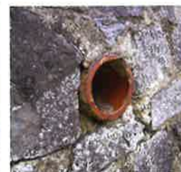
Élément en terre cuite dans un mur de soutènement.
