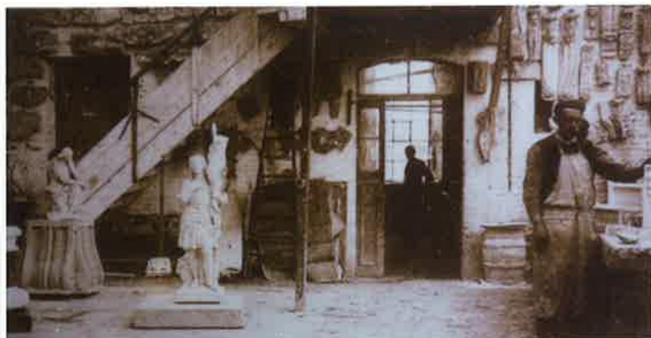
Usine Sainte-Aldegonde à Cousolre, vue de l'atelier de sculpture.
